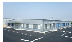
大分工場 (大分県大分市) 工場面積: 2,359㎡ 設備: クリーンブース20㎡×4 / フォークリフト/各種工具一式/その他開発設備
