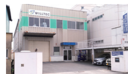
守口工場 (大阪府守口市) 工場面積: 907.2㎡ 設備: 汎用旋盤 / 溶接機 / フォークリフト / 汎用フライス / CAD 各種 / クレーン×3 / エアー / チラー / 各種工具一式
