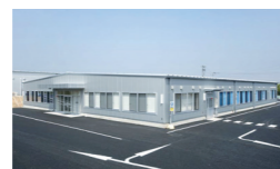
大分工場 (大分県大分市) 工場面積: 2,359㎡ 設備: クリーンブース 20㎡ x4 / フォークリフト / 各種工具一式 / その他開発設備
