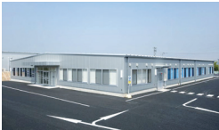
大分工場（大分県大分市） 工場面積：2,359㎡ 設備：クリーンブース 20㎡×4／フォークリフト／各種工具一式／その他開発設備
