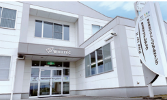
熊本テクニカルセンター（熊本県合志市） 床面積：382㎡（2階建）
